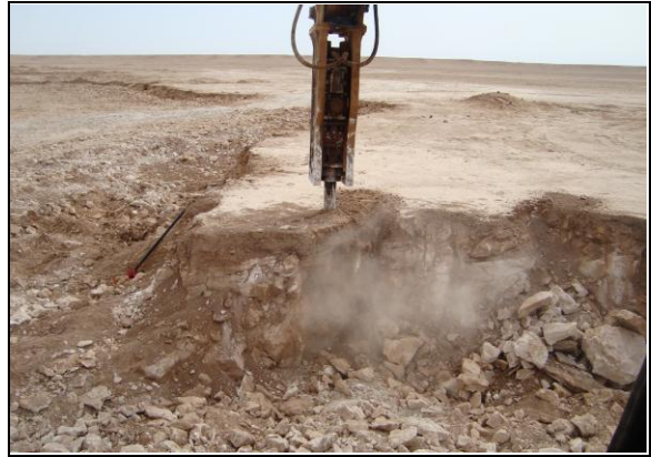
صورة ٤: قلع الحجر الجيري من الطبقة المنتجة في منطقة الدراسة التي يزيد سمكها عن متر، ولايزيد ميلها عن ٥ درجات ويتم القلع بواسطة (النقار)، حيث يستخدم الحجر لاغراض البناء او تقطيعه على شكل (حلان).
